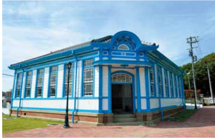
旧事務所。多機能トイレや授乳室が設置された
